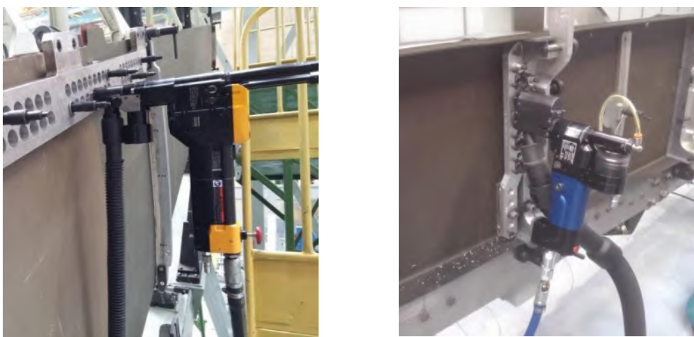
Рисунок 34 – СМАП установленный в кондукторе
